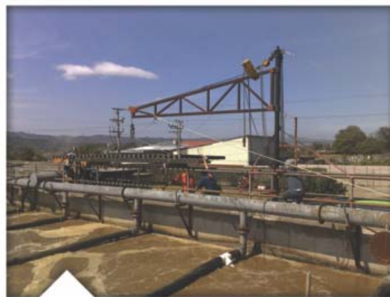
Grilles amovibles avec les diffuseurs Snappy Saddle™ de SSI et une structure en acier inoxydable 304 SS pour remplacer un système latéral flottant ne fonctionnant pas correctement.
