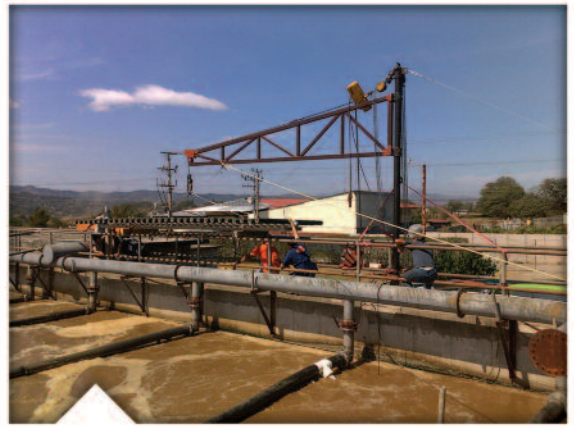
Aushebbares Gitter mit SSI Snappy Saddle™ Belüftern und ein 304 Niro-Rahmen, der ein leistungsschwaches schwebendes Seitensystem ersetzt.
