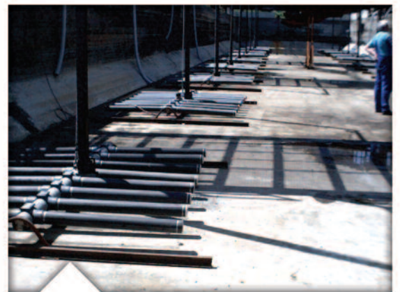
Diese aushebbaaren Rahmen auf Führungsschienen mit Rohrbelüftern waren mehr als 10 Jahre in dieser kommunalen Kläranlage in Betrieb.
